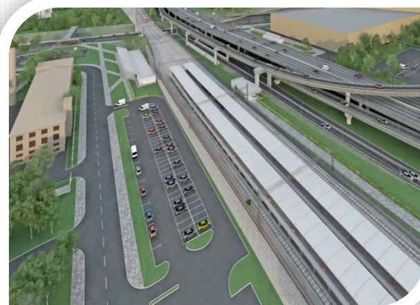
ТПУ Ростокино Ведутся работы по строительству современного транспортно- пересадочного узла ТПУ Ярославская
